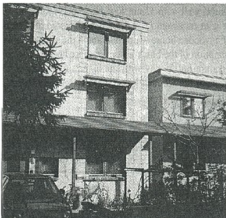
写真2 二重壁ブロック住宅 (左) と木造住宅 (右)
