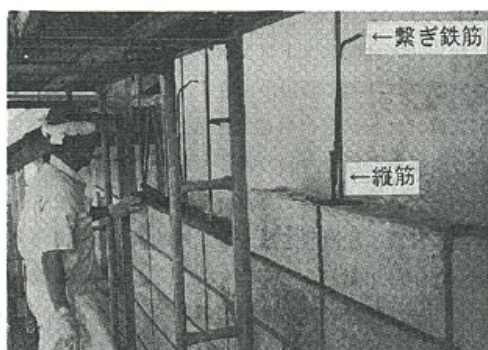
写真3 外装仕上げブロック積み
